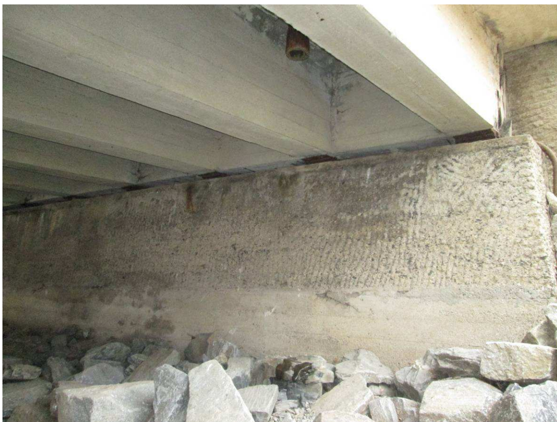
Pohled na OP1. Výluhy, koroze ložisek. NK – průsaky a výluhy.
